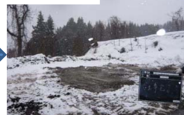
解体工事完了
