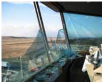
福島空港管制塔のガラス破損状況
