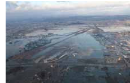
津波により空港アクセスが失われ孤立化した仙台空港
