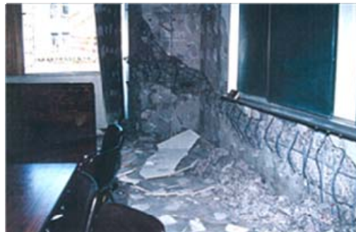
内部の被災状況
