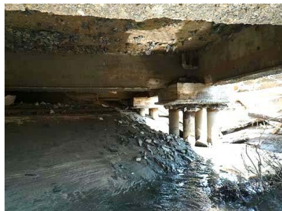
建物基礎が露出
