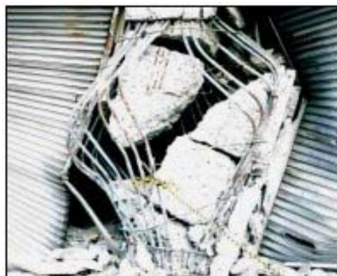
店舗1階柱の圧壊
