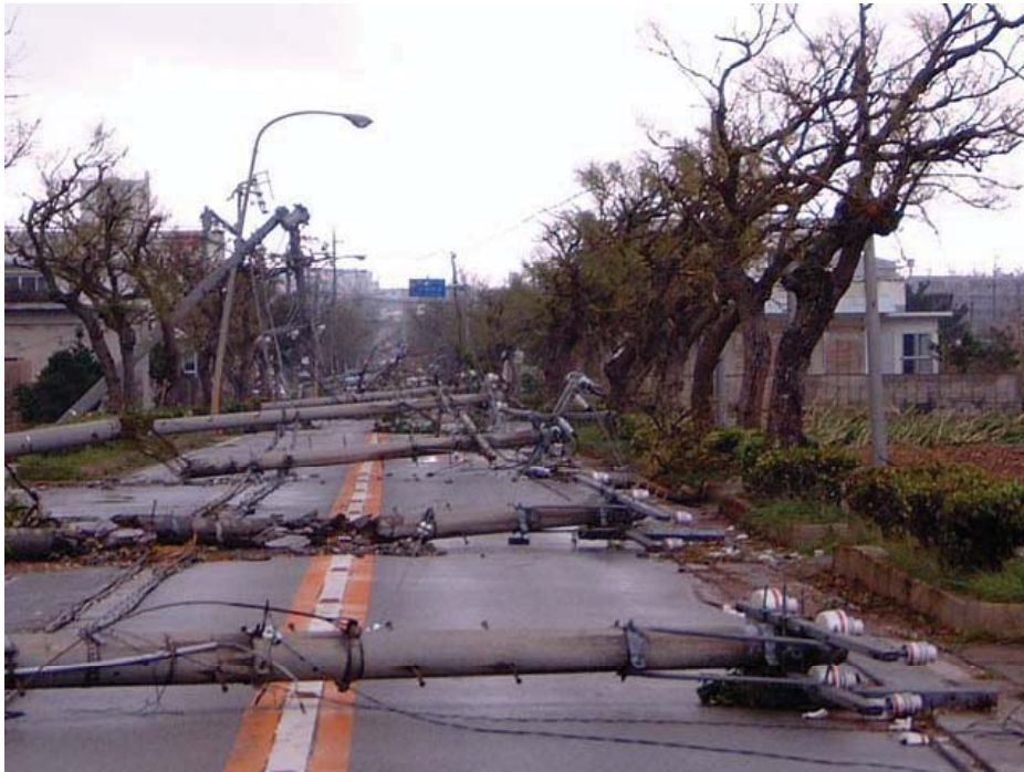
<台風により倒壊した電柱>
