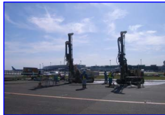
新千歳空港の液状化対策施工状況
