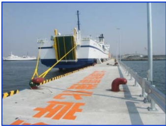
函館港の耐震強化岸壁の整備
