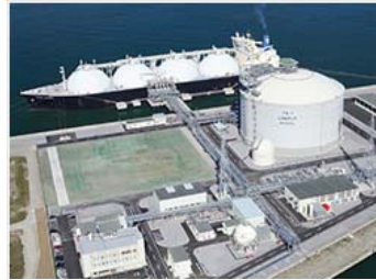
石狩LNG基地写真
