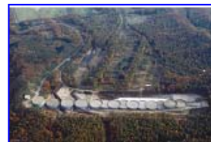
樽前山砂防堰堤群の整備
