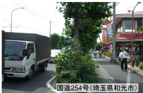
国道254号(埼玉県和光市) 見通しの障害事例
