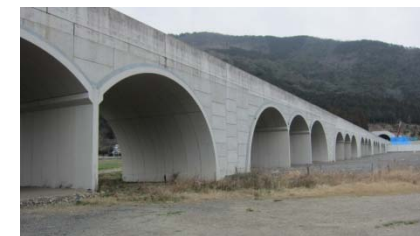
アーチカルバート（国道10号延岡道路 L=129m）
