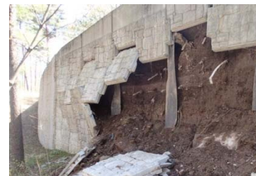
補強土壁の壁面パネル落下(H25.4) → 片側交互規制、大型車通行止め → 1年以上経過の現在も復旧できず
