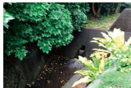
大谷川砂防施設
