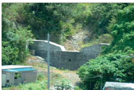
八ツ瀬川砂防施設
