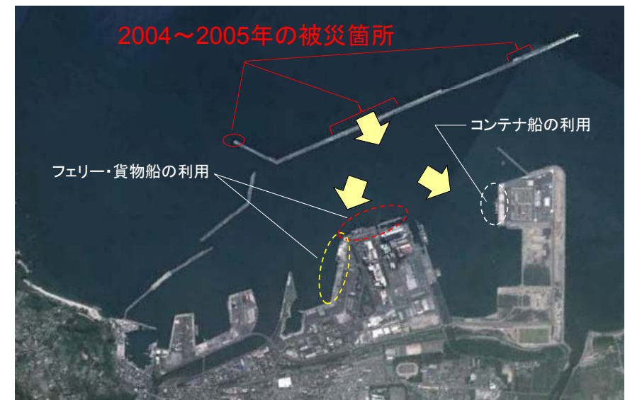
志布志港における防波堤の被災事例
