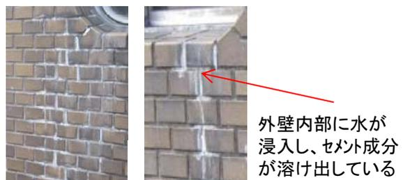
外壁内部に水が浸入し、セメント成分が溶け出している
