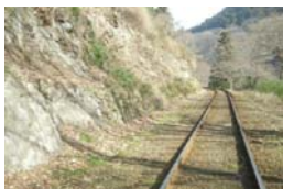
【落石等防止設備】
