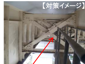
増設した対傾構
