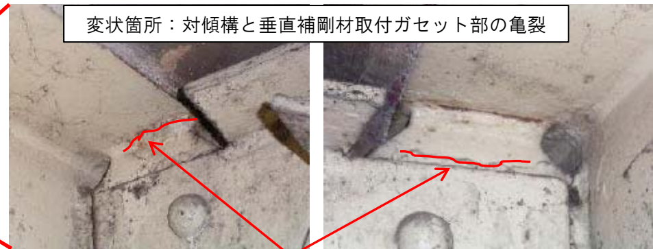
溶接部の亀裂
