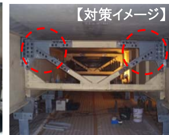
補強部材の取り付け
