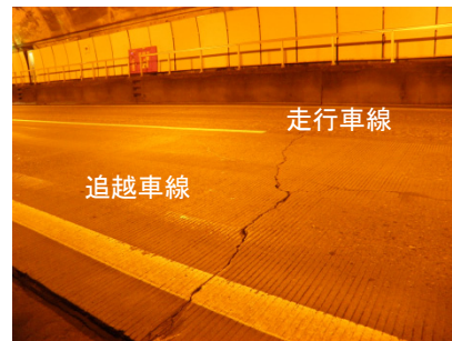
路面隆起によるクラック
