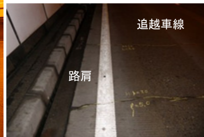
路面隆起による段差
