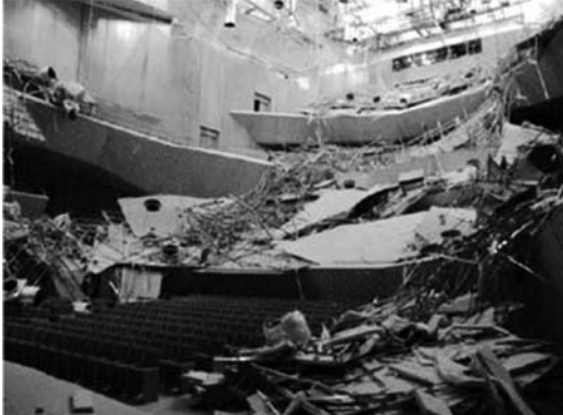
ホール天井の脱落
