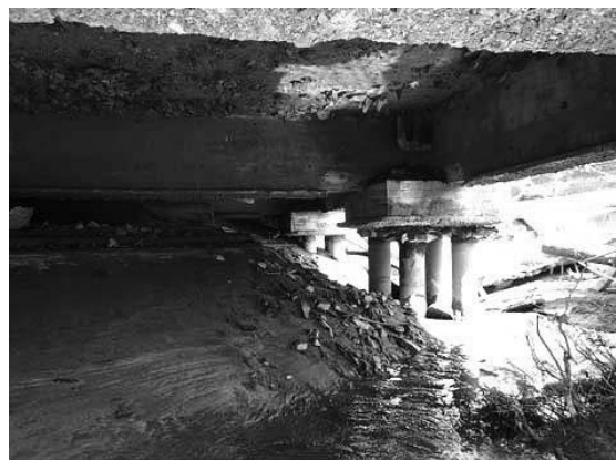
建物基礎が露出
