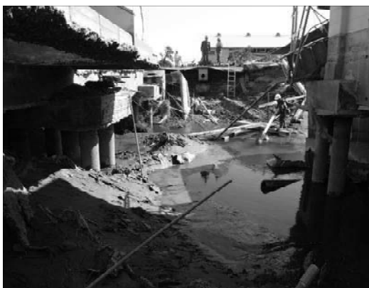
庁舎周囲の地盤流出
