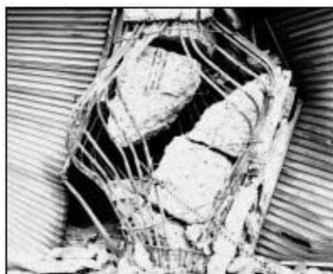
店舗1階柱の圧壊
