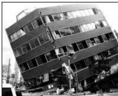
事務所ビル1, 2階の崩壊
