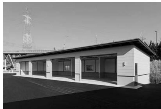
神戸税関境支署(車庫棟)
