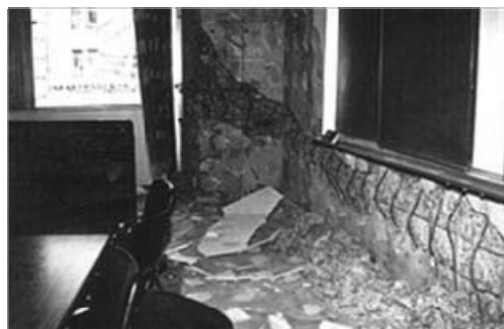
内部の被災状況
