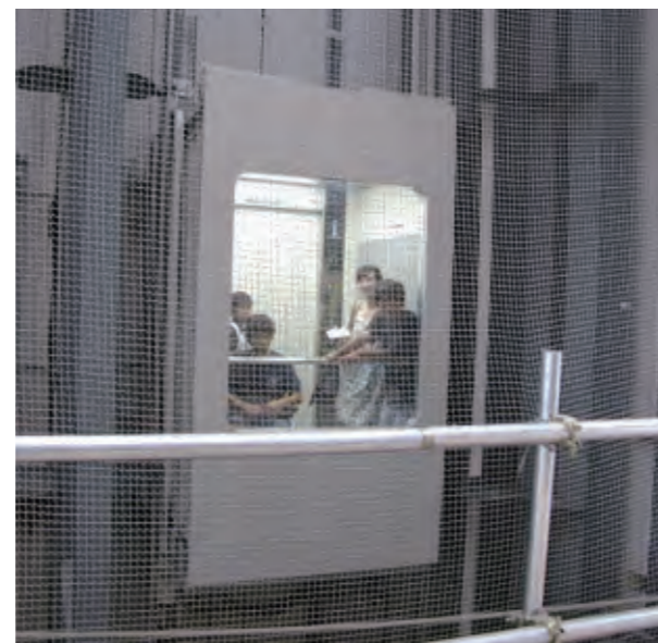
施設内に整備したエレベーター
