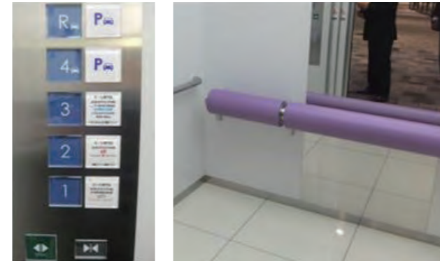
通常より大きなボタン 高齢者等にも配慮した腰掛けの設置
