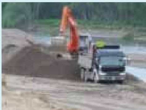
十勝川河道掘削
