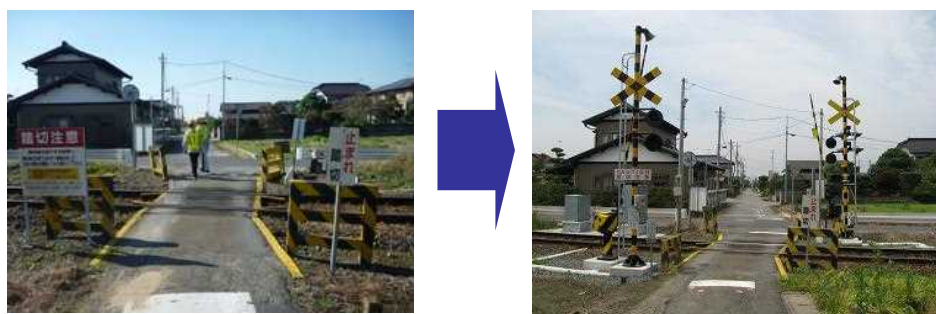
図18:踏切遮断機・警報機の整備
