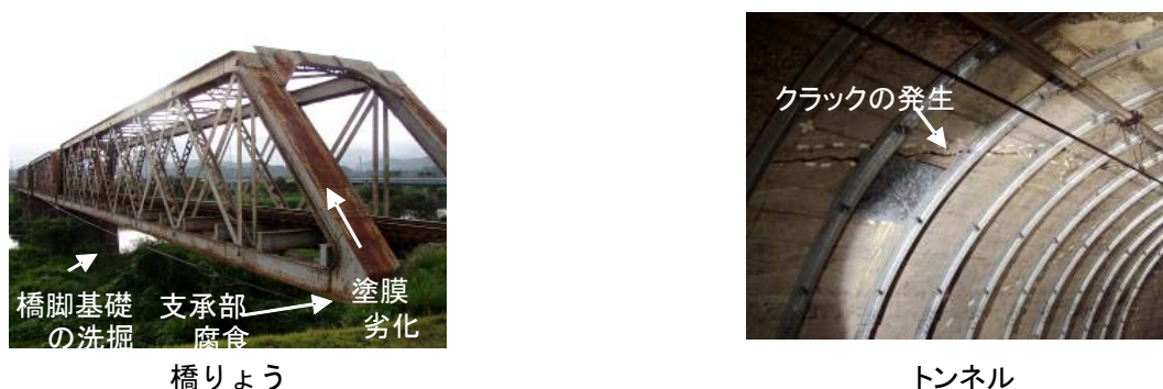
図4：老朽化が進んでいる施設の例
