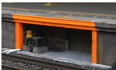
ホーム下の待避スペース
