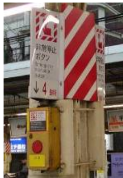
非常停止押しボタン
