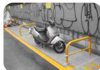
チェーンでつなぐためのバリカーを設置
