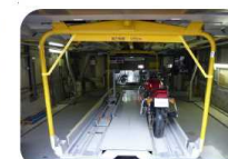
機械式駐車装置のバレットに自動二輪車固定スライダーバレットを2台設置
