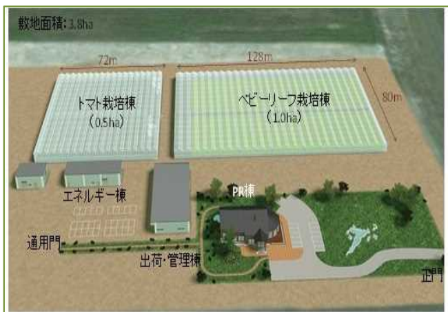
植物工場(平成26年8月完成)
