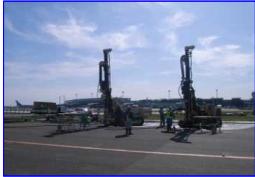
新千歳空港の液状化対策施工状況
