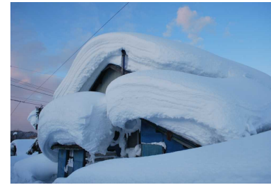
岩見沢市美流渡の積雪の様子 (平成24年2月撮影)
