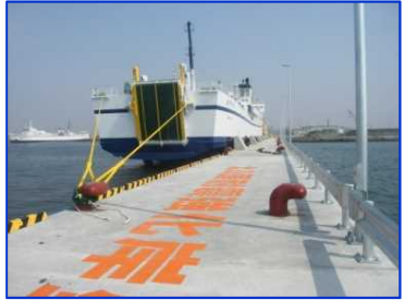
函館港の耐震強化岸壁の整備
