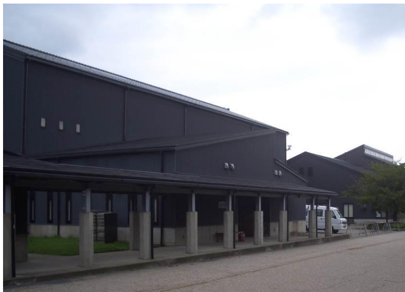
写真1-7 第2回調査で職人育成研修組織の先行事例のひとつとして注目した「金沢職人大学校」
