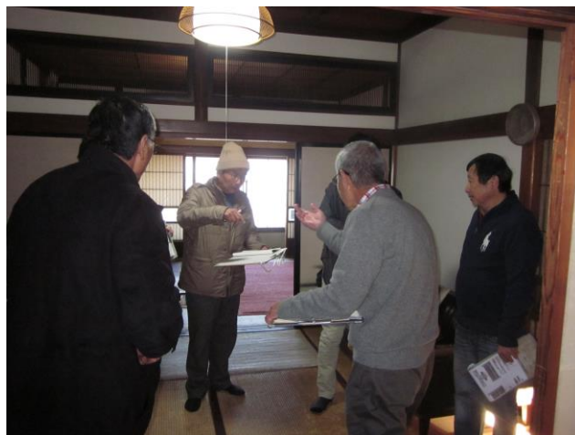
写真 4-9 第 6 号研修による建物調査
