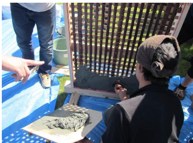
写真1-8 模型を用いたる左官の模擬研修
