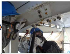
Cold Spray現場施工
