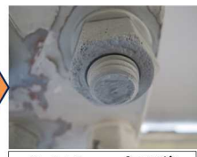
Cold Spray処理後
