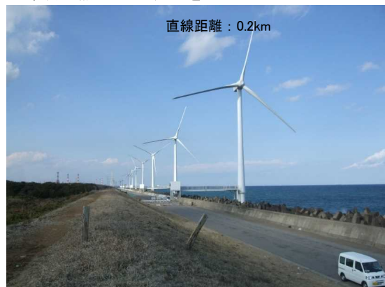
<観測地点Aから北方向を望む>
