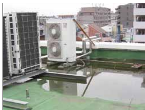
写真1 屋上の水たまり
