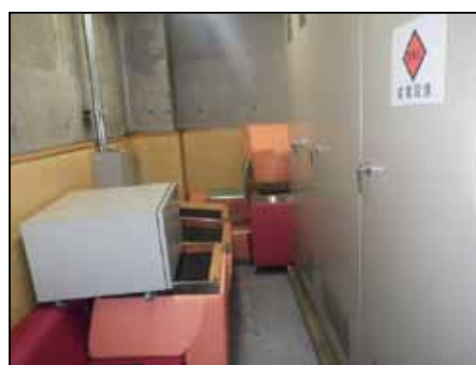
写真5 電気室内の備品
