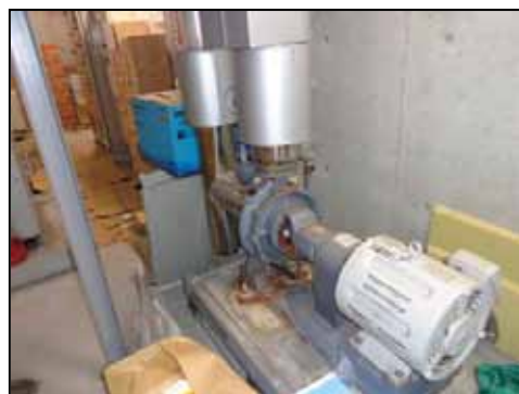
写真7 冷温水ポンプ
