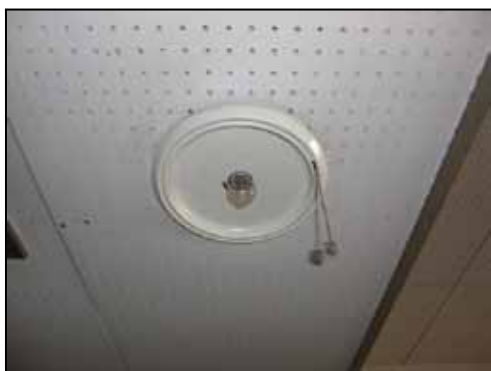
写真3 非常照明器具 (電池内蔵形、白熱電球)
