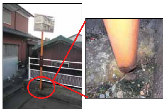
写真11 構内カーブミラーの支柱
