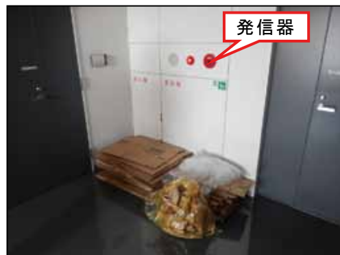
写真9 屋内消火栓前の障害物
