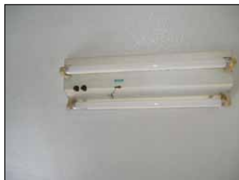
写真4 非常照明器具 (電池内蔵形、蛍光灯)
