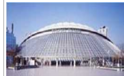
雨水利用施設の事例
