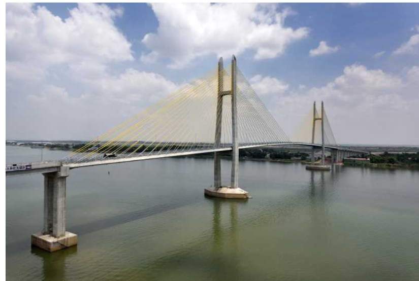
状況写真(2015年3月)
