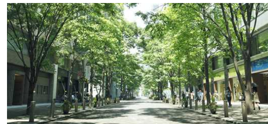
壁面後退(民地)、空間の設え、イベントの実施等により賑わいを創出する丸の内仲通り
