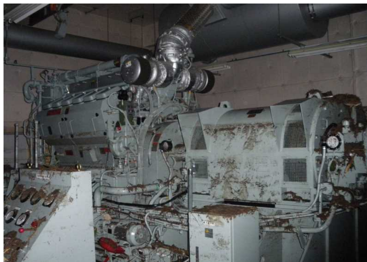
⑤津波により水没した自家用発電設備
