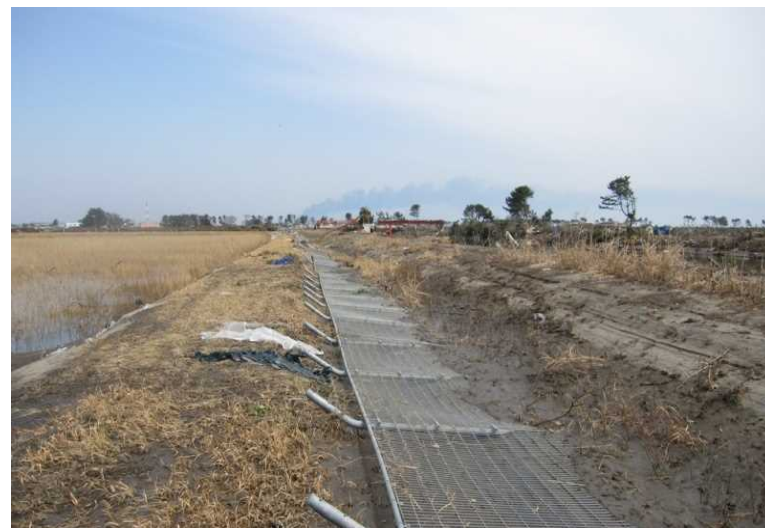
③津波により倒壊した場周柵
