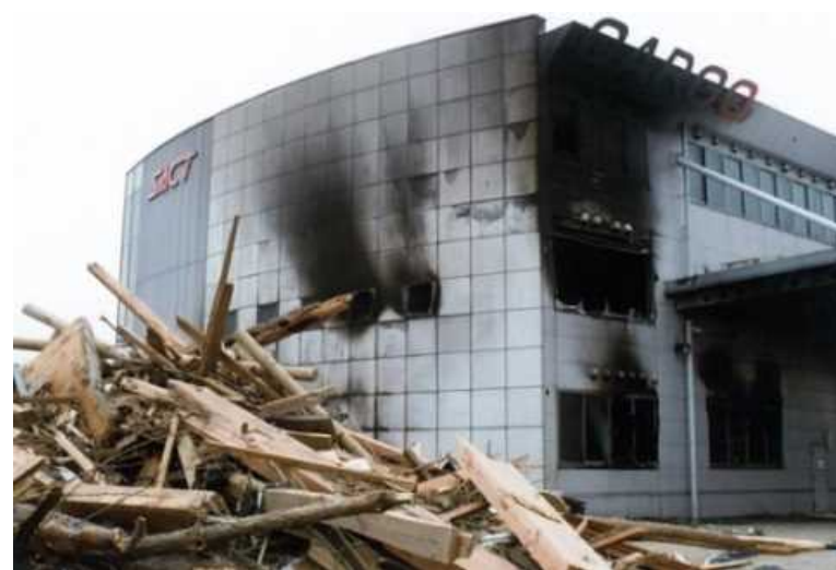
⑥津波火災により焼失した貨物施設
