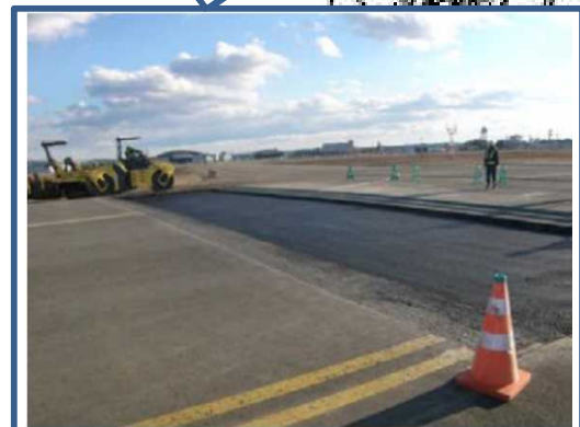
民間航空機の運航再開に向けた舗装復旧
