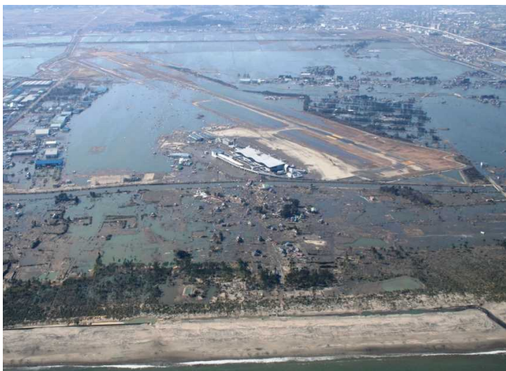
①津波により冠水した仙台空港 (3月12日)
