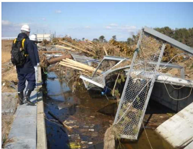
④津波により冠水した鉄道トンネル (空港側入口付近)
