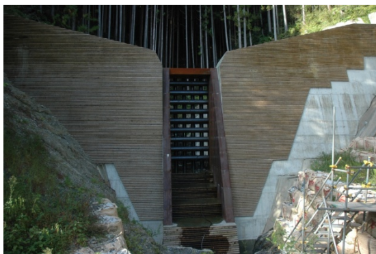
吉野川水系吉野川（高知県土佐郡） 『砂防堰堤（木製残存型枠）』
