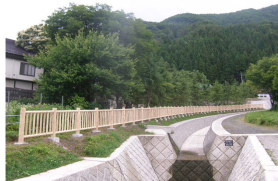
利根川水系西の沢（群馬県みなかみ町） 『木製転落防止柵』
