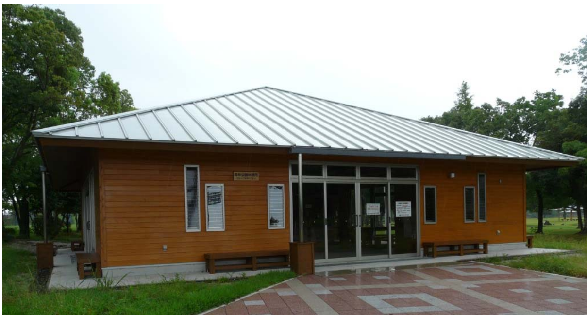
県立森林公園（佐賀県佐賀市）：休憩所
