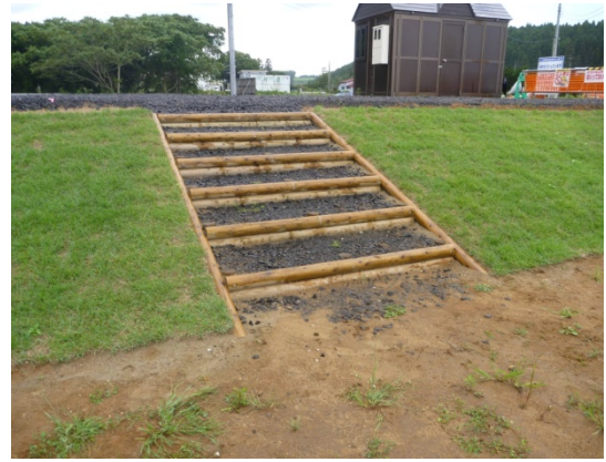
高瀬川水系高瀬川（青森県上北郡） 『山腹工（木柵）』
