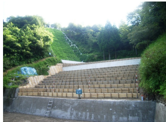
天降川水系大窪谷（鹿児島県霧島市） 『山腹工（木柵）』
