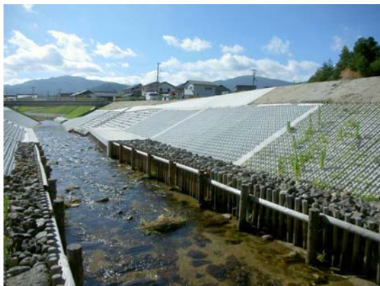
野田川水系岩屋川（京都府与謝郡） 『杭柵護岸工』
