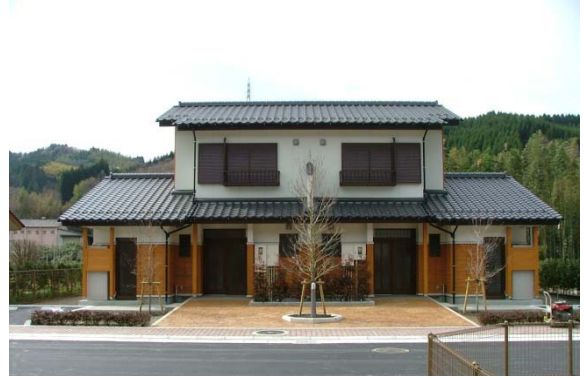
大分県九重町 豊後中村住宅 外観
