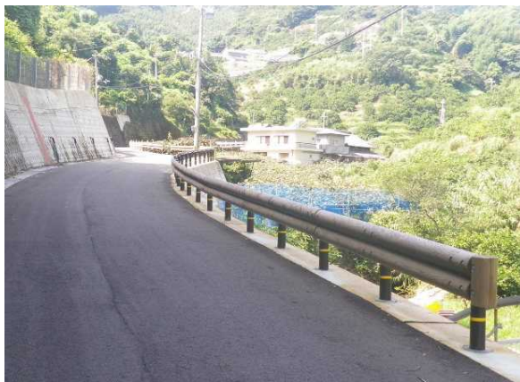
木製防護柵 県道 引尾下津線 (和歌山県海南市)
