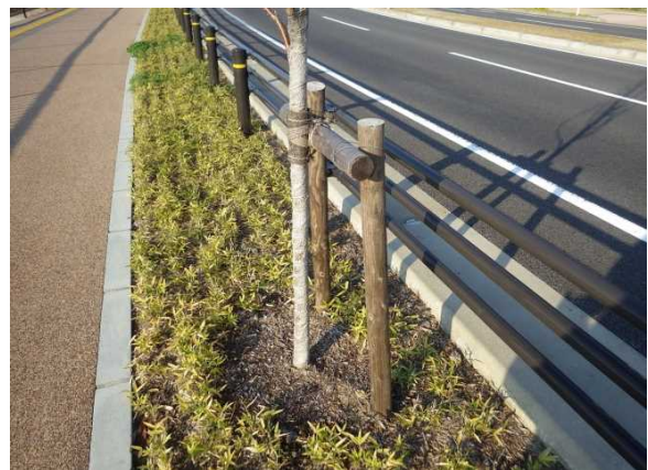
樹木の支柱 国道34号 (長崎県大村市)
