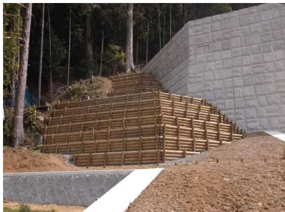
狩野川水系（静岡県伊豆市） 『土留工』
