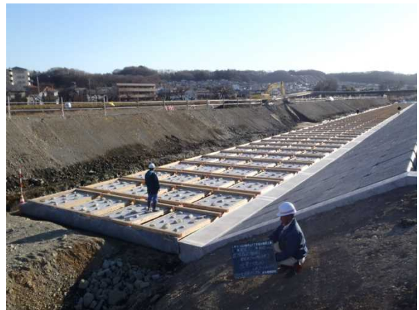
多摩川水系浅川（東京都日野市） 『根固め工』
