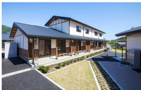
岩手県大槌町 おがくち 大ヶ口地区 外観
