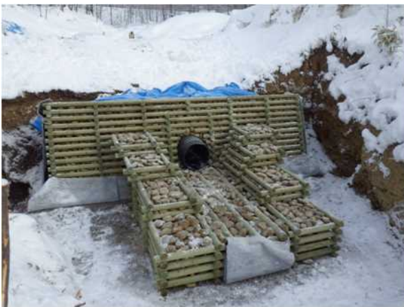
天塩川水系サンル川 （北海道上川郡下川町） 『小規模沢処理工』
