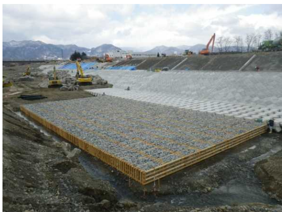
信濃川水系犀川（長野県長野市） 『木工沈床』
