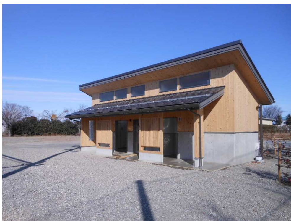
若泉運動公園（埼玉県本庄市）：便所棟
