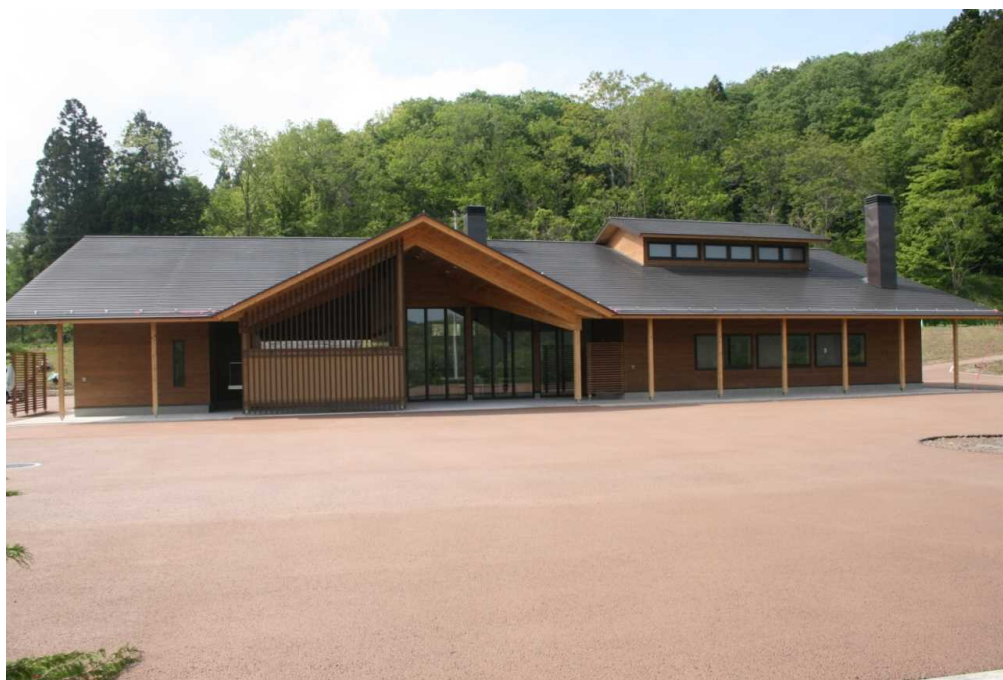
国営みちのく杜の湖畔公園（宮城県柴田郡川崎町）：小野分校
