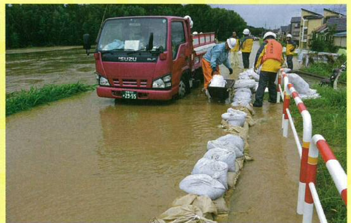
浸水被害を軽減するため、懸命に土のうを積む桂川・小畑川水防事務組合の水防団員ら
