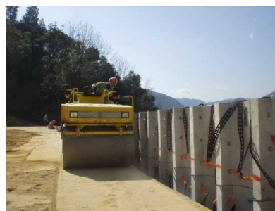
写真-1 盛土材料の締固めの状況
