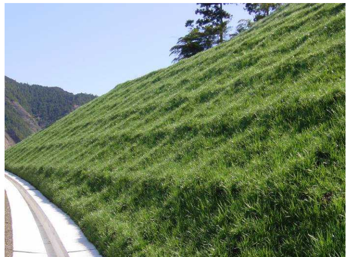
写真一 3 全面緑化が可能で景観保全 (左: 施工完了、右: 施工後)
