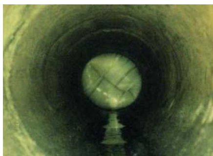
写真—1 反転挿入状況
