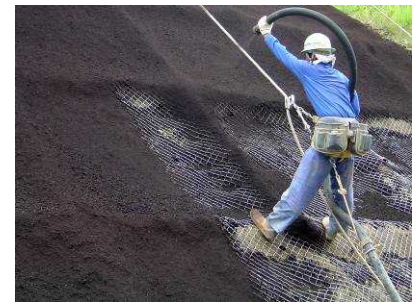
写真一 2 施工状況 (左: ジオグリッド設置、中: 改良土吹付、右: 植生基材吹付)
