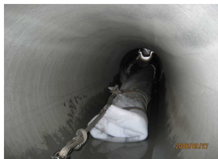
写真—2 引き込み挿入状況
