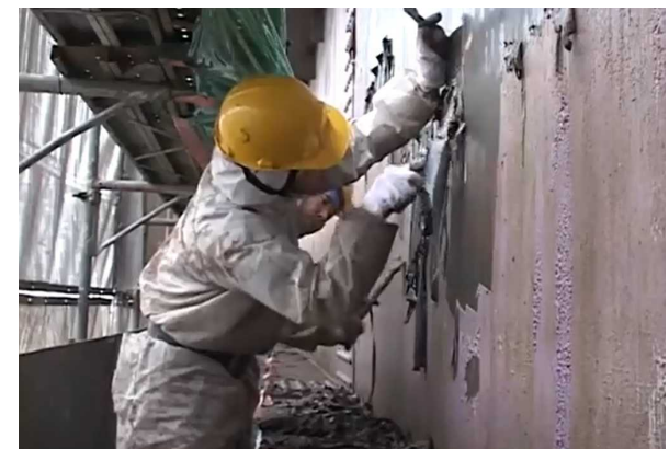
写真一 塗膜除去状況
