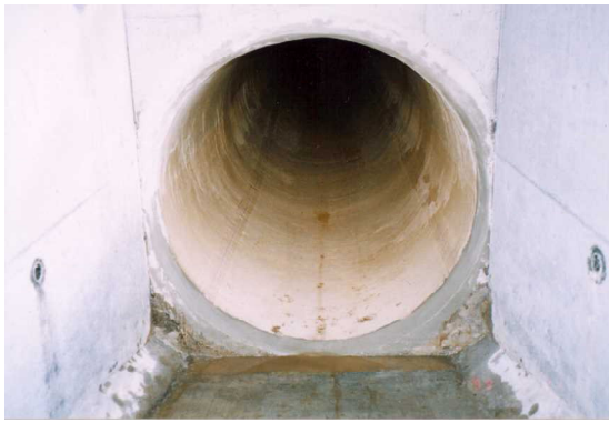
写真一 円形樋管更生
