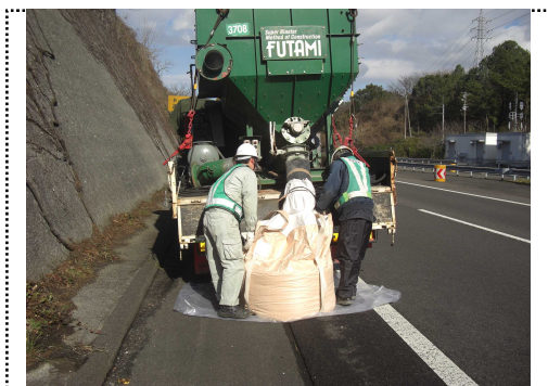
写—3 集塵機より粉塵排出
