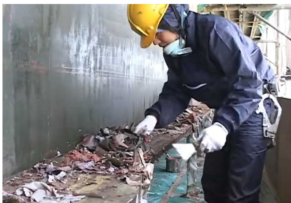
写真一 除去塗膜の回収
