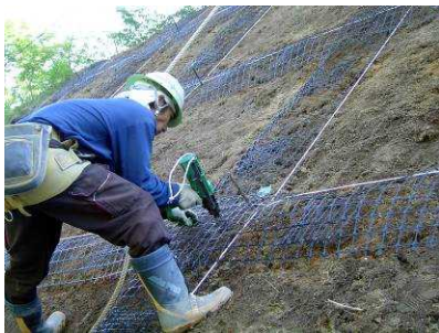
写真一 2 施工状況 (左: ジオグリッド設置、中: 改良土吹付、右: 植生基材吹付)
