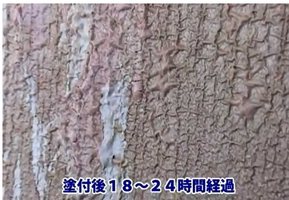
写真一 塗膜軟化状態の例
