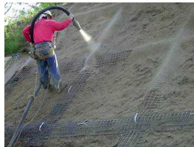
写真一 2 施工状況 (左: ジオグリッド設置、中: 改良土吹付、右: 植生基材吹付)
