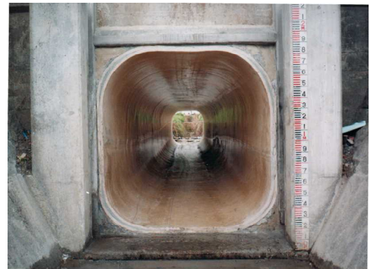
写真二 矩形樋管更生
