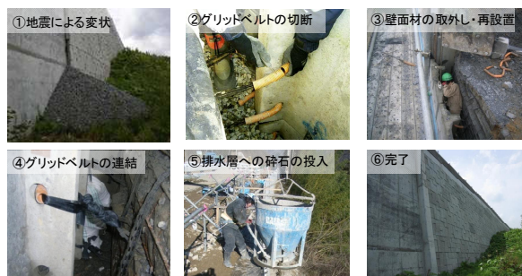
写真-3 2008年岩手・宮城内陸地震を受けたアダムウォールの壁面の修復事例
