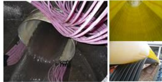
管口部の状況 (新潟県十日町市) 内表面と保護層下部 出所) 東亜グラウト工業株式会社 資料
