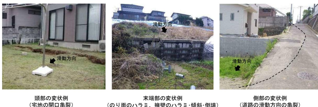
図Ⅲ.2.1 滑動崩落を示唆する変状の例
