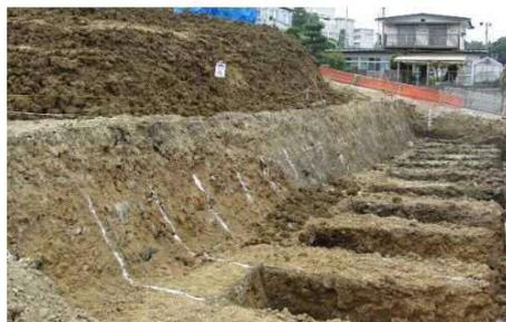
図参 6.1-③ 固結工法（中層混合処理工）の施工状況（N地区の例）
