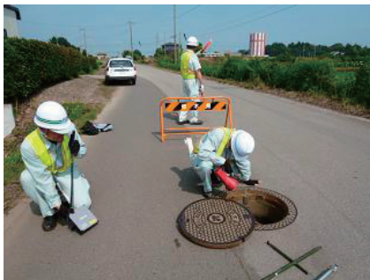
管路施設の緊急点検 (栃木県)
