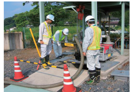
汚水溢水時のポンプによる仮排水 (益子町)
