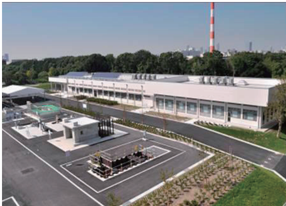
下水道技術実習センター全景
