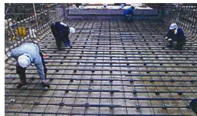
現場施工の現状(イメージ)
