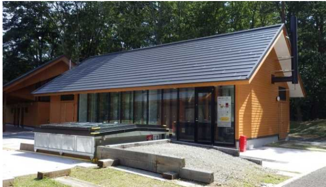
設備棟とチップヤード(手前)
