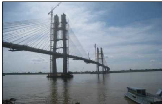
写真: ネアックル橋
