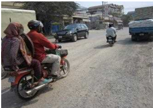
コンクリート舗装
