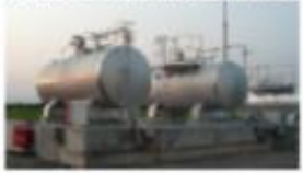
純水素型燃料電池 0.8kW × 10基 4H 2 シリンダー×4基 トルエン 貯蔵タンク
