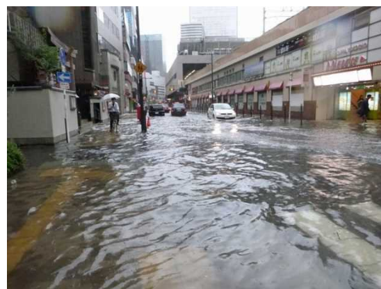
平成25年8月 大阪市梅田駅浸水状況
