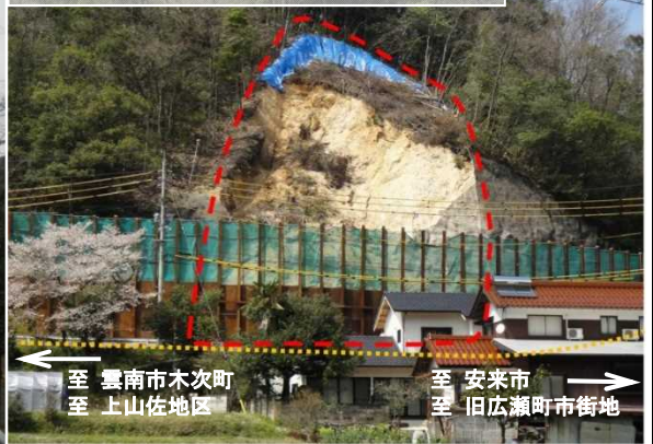
② 応急対策工事後の状況 (H26.12.19~)
