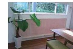
放射冷暖房用プラスチック製ラジエータ
