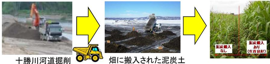
河道掘削で発生する泥炭土は、堤防の盛土材料等としては不適である一方、通気性・保水性に優れているため、客土として農地へ有効活用
