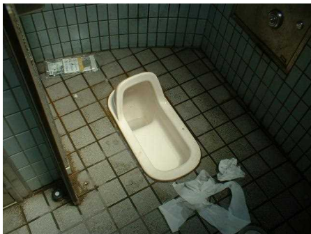
清掃前の公衆トイレ状況
