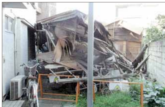
墨田区：行政代執行にて除却した空き家
