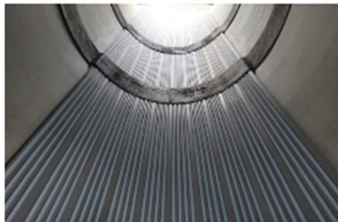
下水熱の利用のため下水管渠内に敷設される熱交換器
