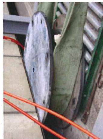
ジャッキアップ後の 免震積層ゴム引き出し
