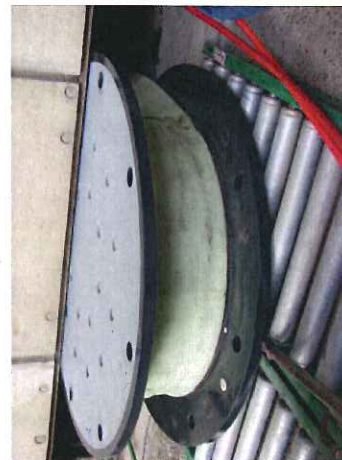
新規免震積層ゴム挿入
