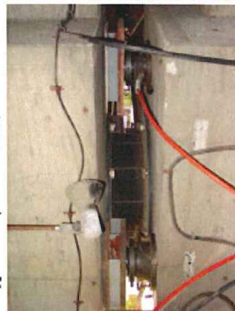
油圧ジャッキ設置
