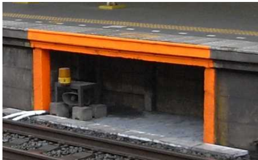
ホーム下の待避スペース
