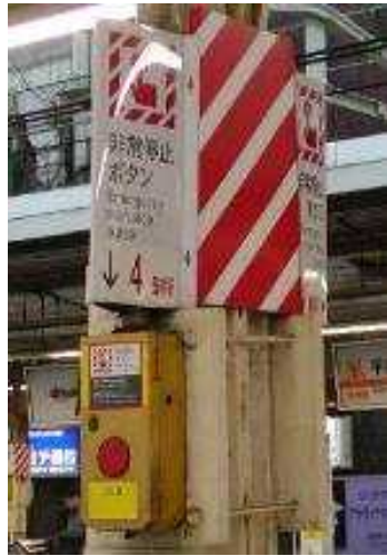
非常停止押しボタン
