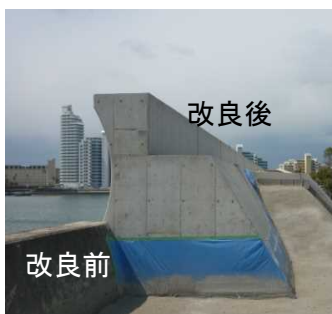
海岸堤防等の改良
