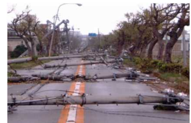
<電柱の倒壊による道路閉塞>
