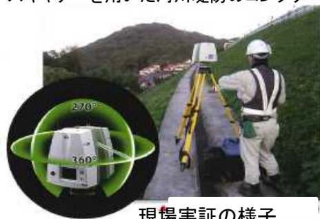
現場実証の様子
