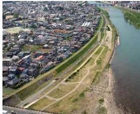
河川堤防の整備
