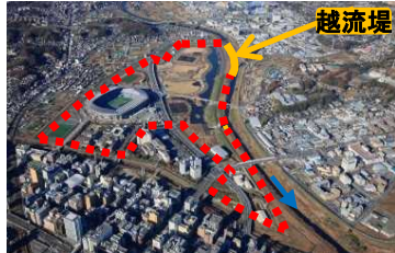
洪水調節施設の整備
