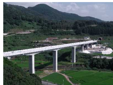
九州新幹線 千綿川橋りょう
