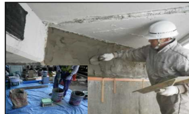
<新設例(断面補修工)>
