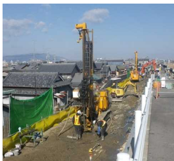
河川堤防の耐震化
