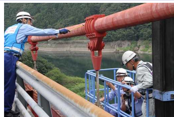
【メインケーブルの近接目視】
