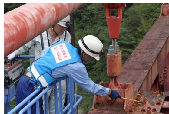
【主桁接合部の近接目視】
