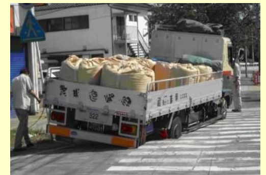
下水管きよに起因した道路陥没
